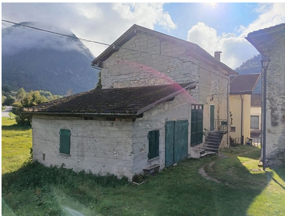
Vista esterna (nord-ovest) - p.ed. 543 - C.C. Pieve Tesino
