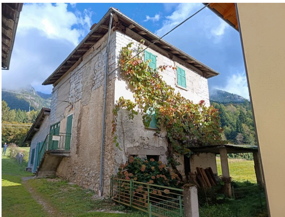
Vista esterna (sud) - p.ed. 543 - C.C. Pieve Tesino
